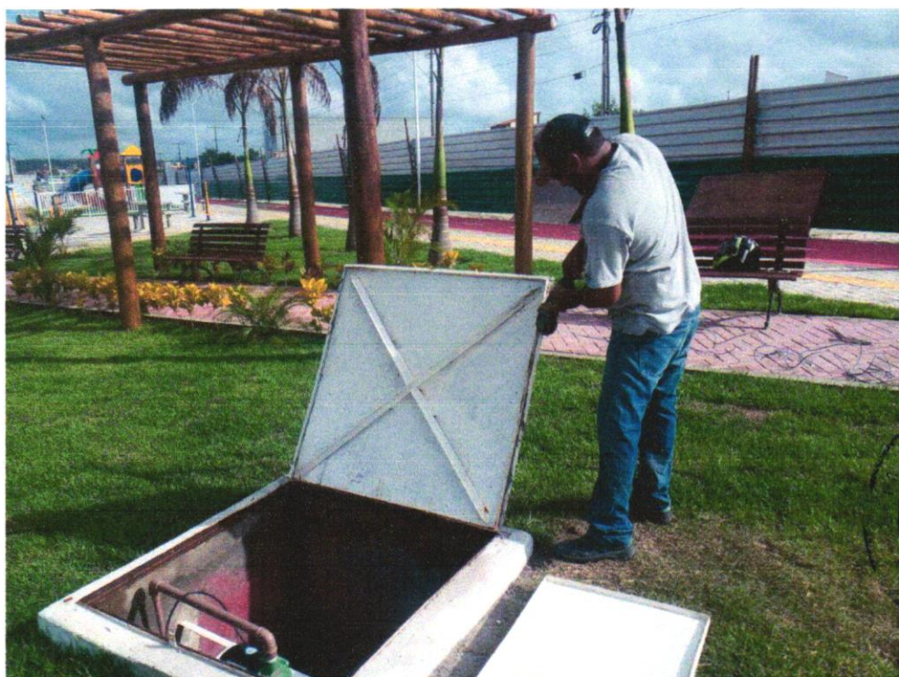
Foto 20 - BOMBA CENTRÍFUGA, TRIFÁSICA, 1 CV OU 0,99 HP, HM 14 A 40 M, Q 0,6 A 8,4 M3/H - FORNECIMENTO E INSTALAÇÃO. AF_12/2020
