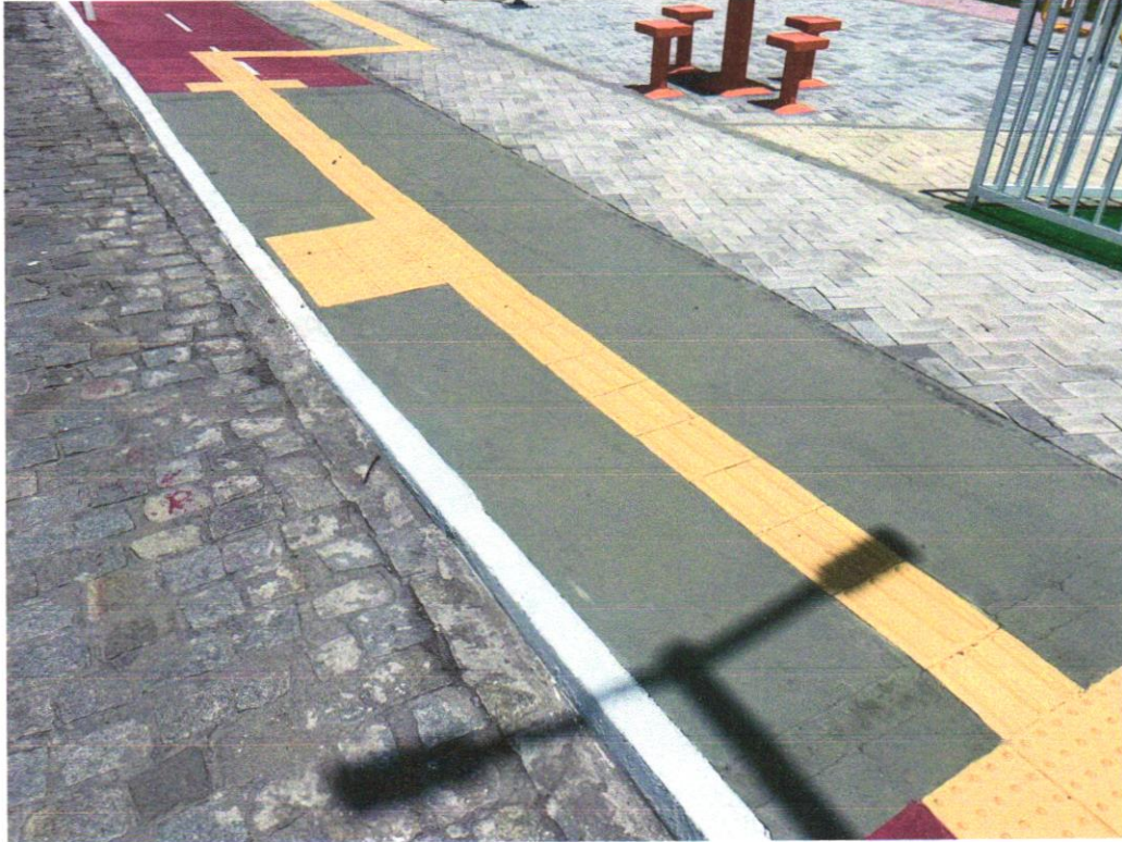
Foto 06 - Piso tátil direcional e/ou alerta, de concreto, colorido, p/deficientes visuais, dimensões 25x25cm, aplicado com argamassa industrializada ac-ii, rejuntado, exclusive regularização de base
