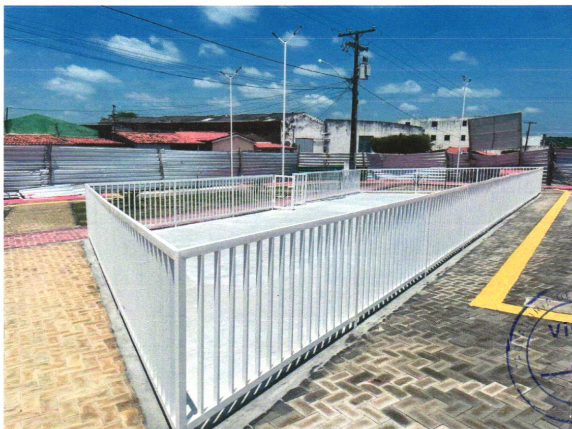
Foto 22 - PISO EM CONCRETO 20 MPA PREPARO MECÂNICO, ESPESSURA 7CM. AF_09/2020
