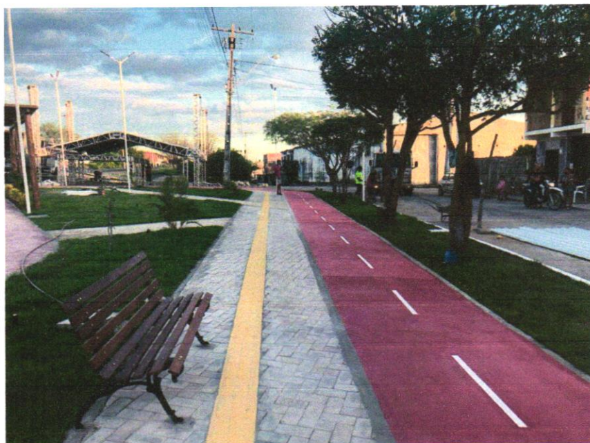
Foto 02 – PINTURA DE PISO COM TINTA ACRÍLICA, APLICAÇÃO MANUAL, 2 DEMÃOS, INCLUSO FUNDO PREPARADOR. AF_05/2021
