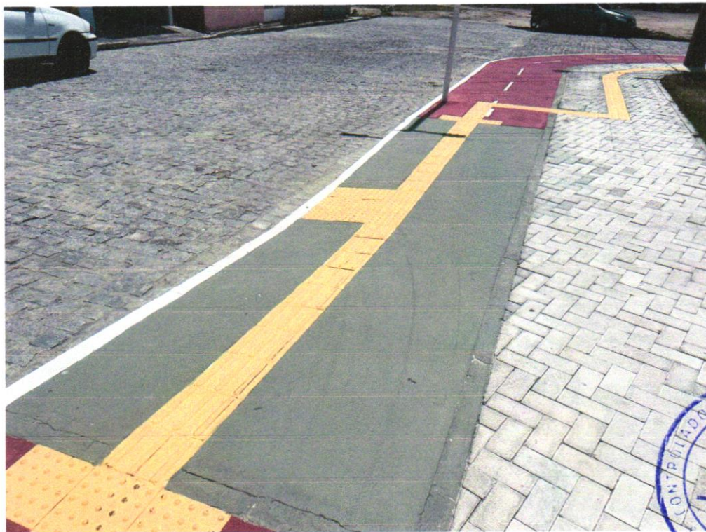
Foto 04 - Rampa padrão para acesso de deficientes a passeio público, em concreto simples Fck=25MPa, despolada, com pintura indicativa em novacor, 02 demãos
