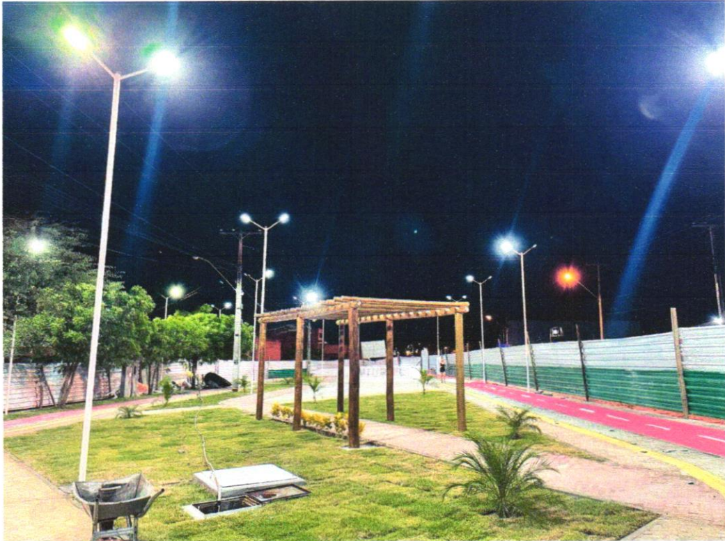
Foto 18 - Fornecimento e assentamento de peças de eucalipto tratado, d=13 a 16cm
