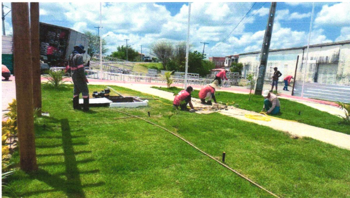
Foto 22 - PISO EM CONCRETO 20 MPA PREPARO MECÂNICO, ESPESSURA 7CM. AF_09/2020
