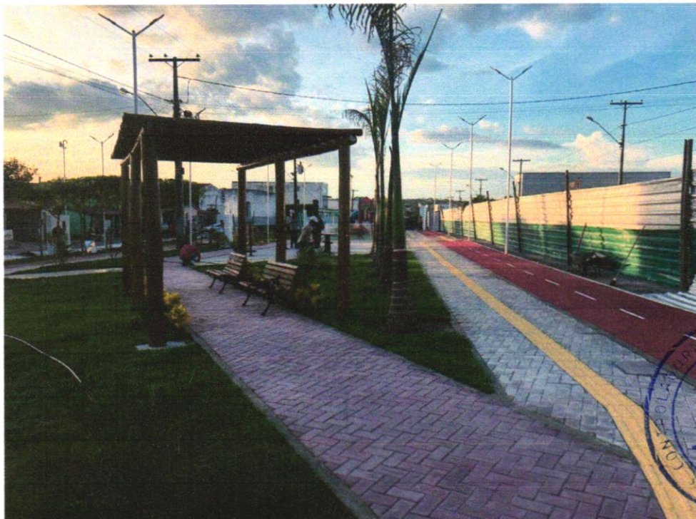
Foto 18 - Fornecimento e assentamento de peças de eucalipto tratado, d=13 a 16cm
