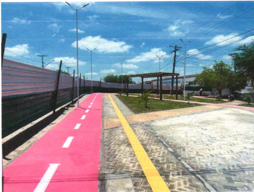
Foto 02 – PINTURA DE PISO COM TINTA ACRÍLICA, APLICAÇÃO MANUAL, 2 DEMÃOS, INCLUSO FUNDO PREPARADOR. AF_05/2021
