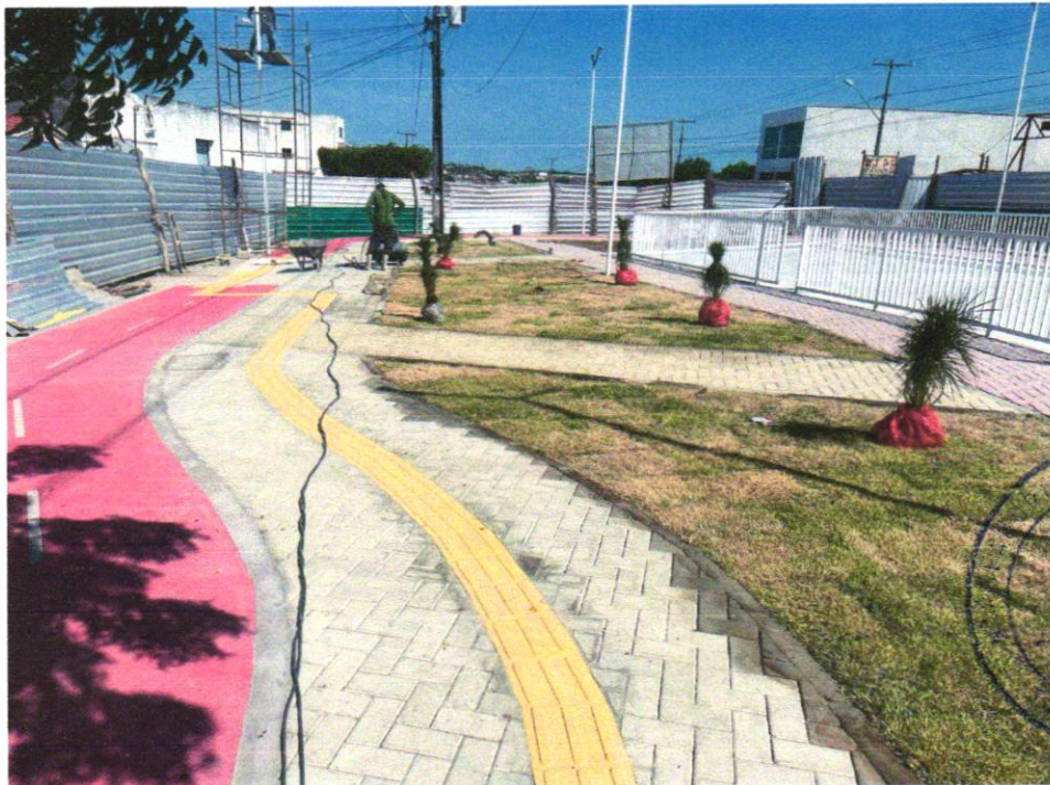
Foto 06 - Piso tátil direcional e/ou alerta, de concreto, colorido, p/deficientes visuais, dimensões 25x25cm, aplicado com argamassa industrializada ac-ii, rejuntado, exclusive regularização de base
